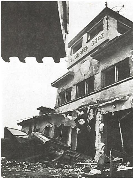
Abbruch des alten Flughafengebäudes 1968 (Foto Amsüss).
