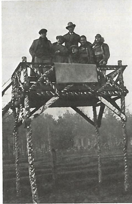
Der „Kontrollturm“ 1930. Im Hintergrund der 1914 angelegte Soldatenfriedhof (Foto: Obst Schalk).
