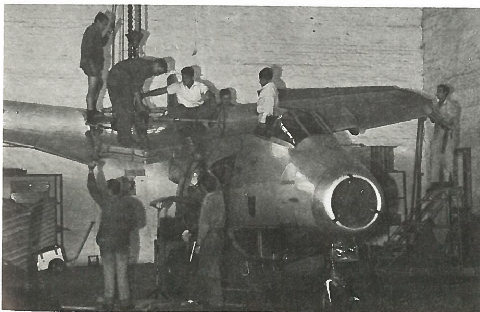
Flächenwechsel an einer SAAB J 29F 1969 (Foto: Bildstelle Graz-Thalerhof).
