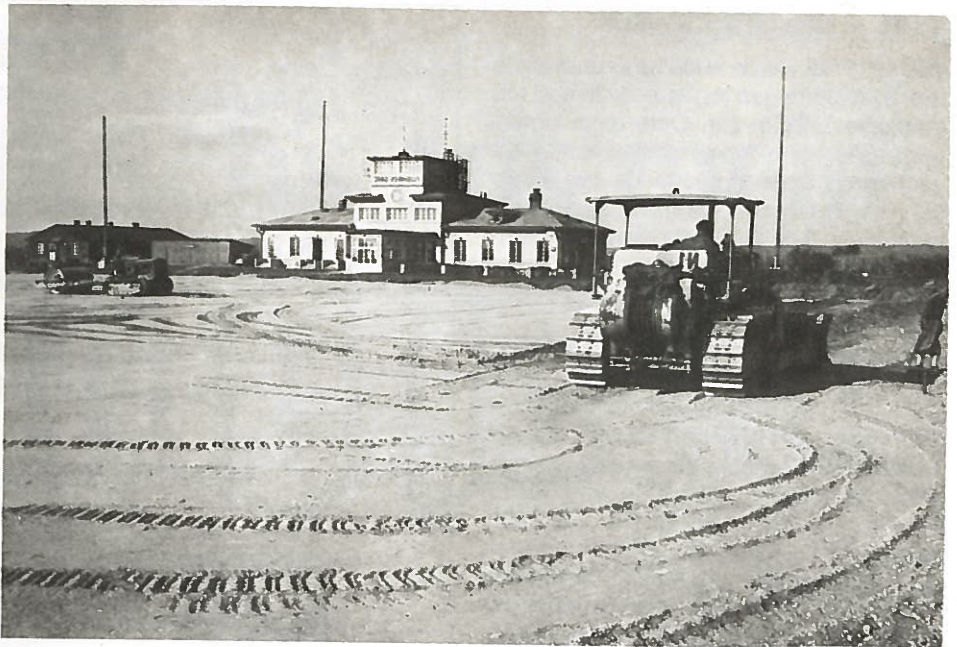
Bau der ersten 1500-m-Betonpiste 1955 (Foto Macher).
