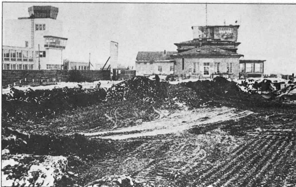
Großbaustelle für den neuen Thalerhof
