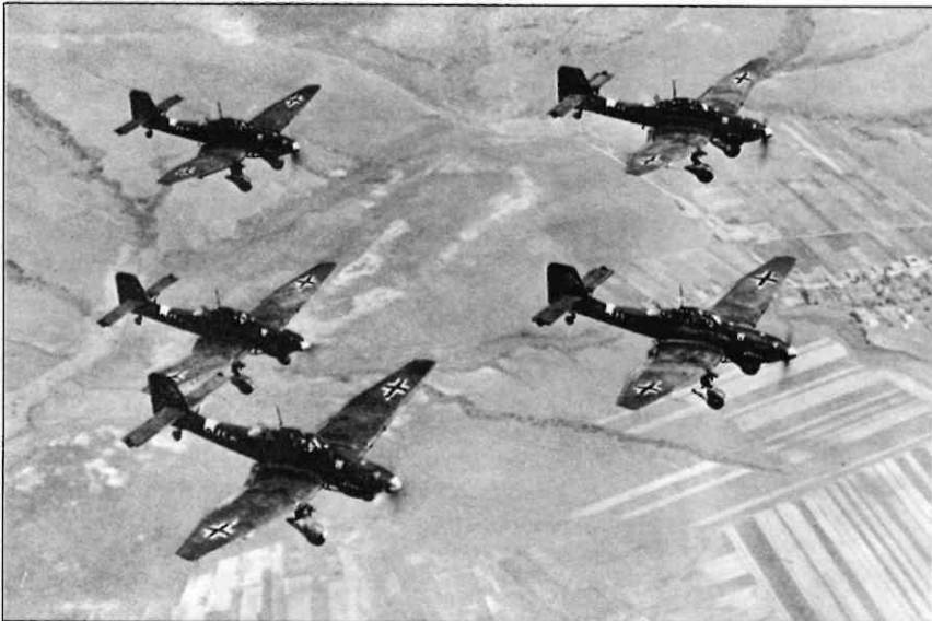
Die Sturzkampfbomber (Stuka) Ju 87 waren auf dem Thalerhof stationiert
