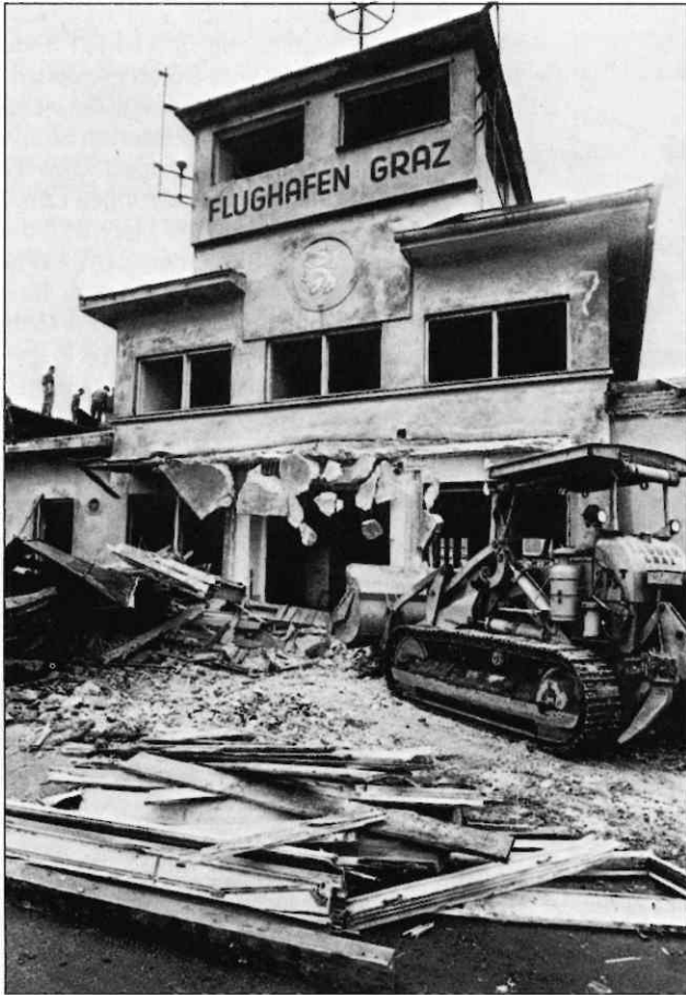
Ausgedehnt – zum Abbruch bereit
