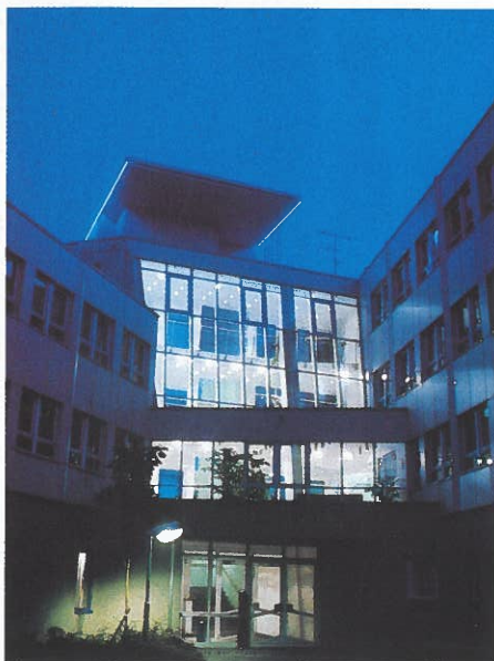
Bürogebäude Foto: ISS Marischka Wien
