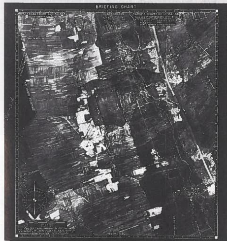
Einsatzkarte mit Gesamtansicht des Flugplatzes Thalerhof, aufgenommen von dem im Mittelmeerraum tätigen alliierten Aufklärungskommando (MAPRC) am 25. 2. 1944 (US-National Archives)
