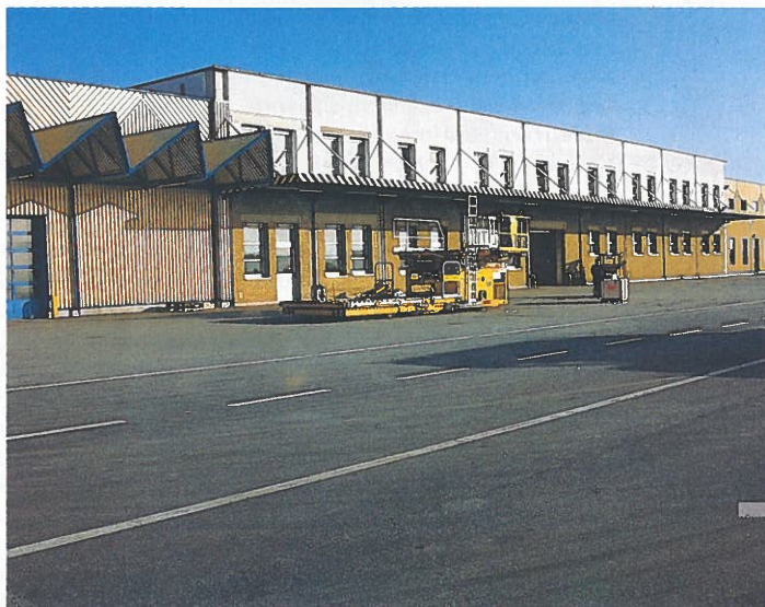
Das neue Frachtgebäude am Airport Graz: Auch hier hatte sich die Zusammenarbeit der Firmen Webern und Ast bereits bestens bewährt.
