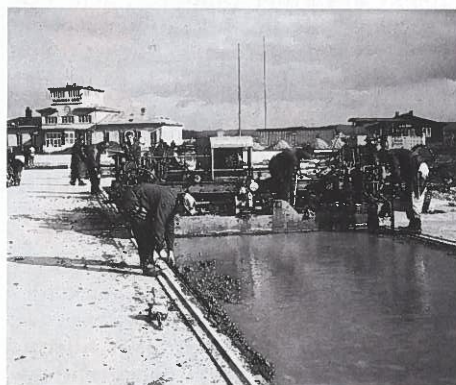
Die Betonpiste entsteht.
