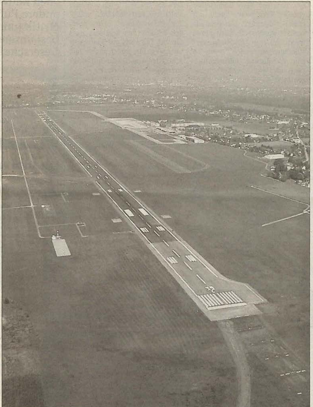
In 50 Nächten asphaltiert: die nunmehr drei Kilometer lange Piste auf dem Flughafen Graz
