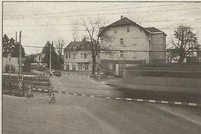
Kreuzungsfrei soll der Bahnverkehr künftig über alle wichtigen Straßen rollen – auch hier beim Bahnhof Puntigam
