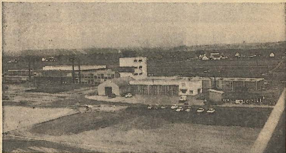
Aus der Luft erkennt man die Ausdehnung der Anlage. Rechts vom Abfertigungsgebäude die Garage. Auf dem Vorfeld wird noch an der Asphaltierung gearbeitet
