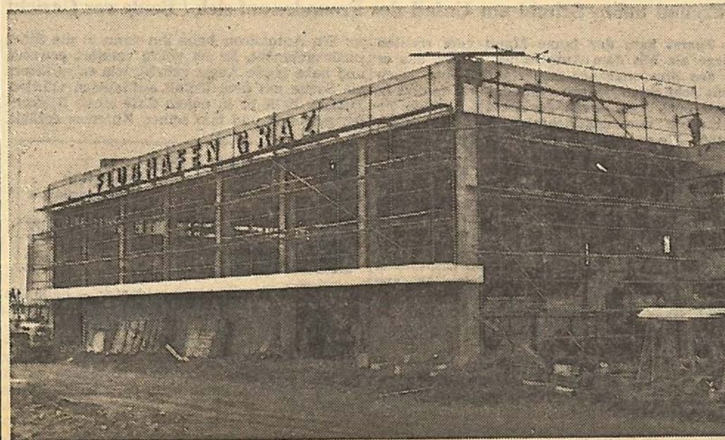
Langsam aber sicher nimmt das neue Flughafengebäude von Graz Gestalt an.
