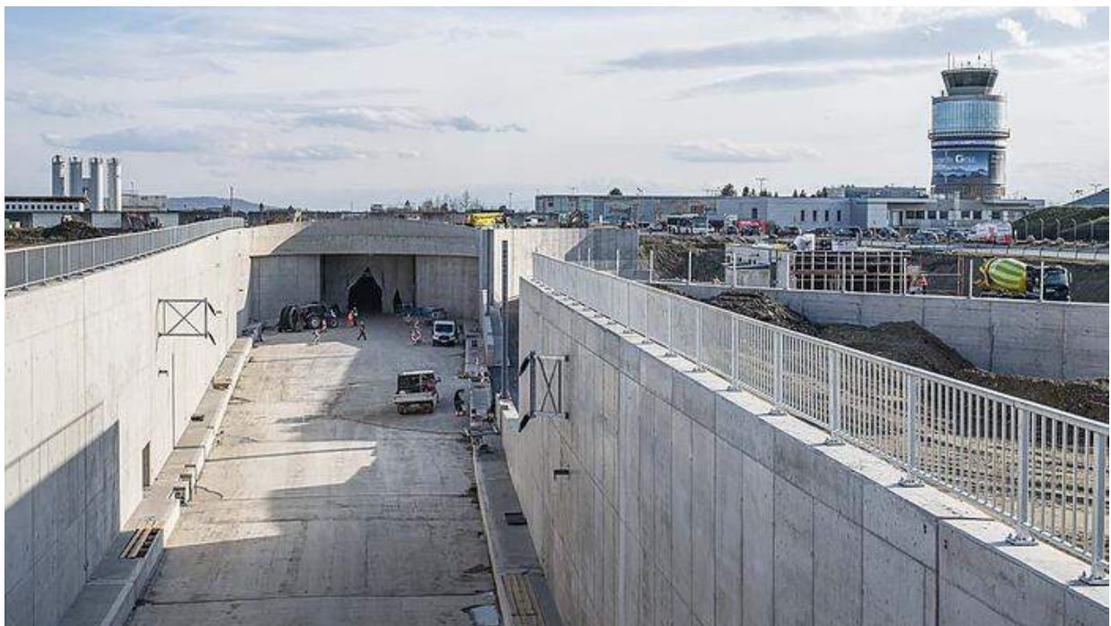
Der aktuelle Blick auf die Baustelle der Koralmbahn nahe dem Flughafen Graz
