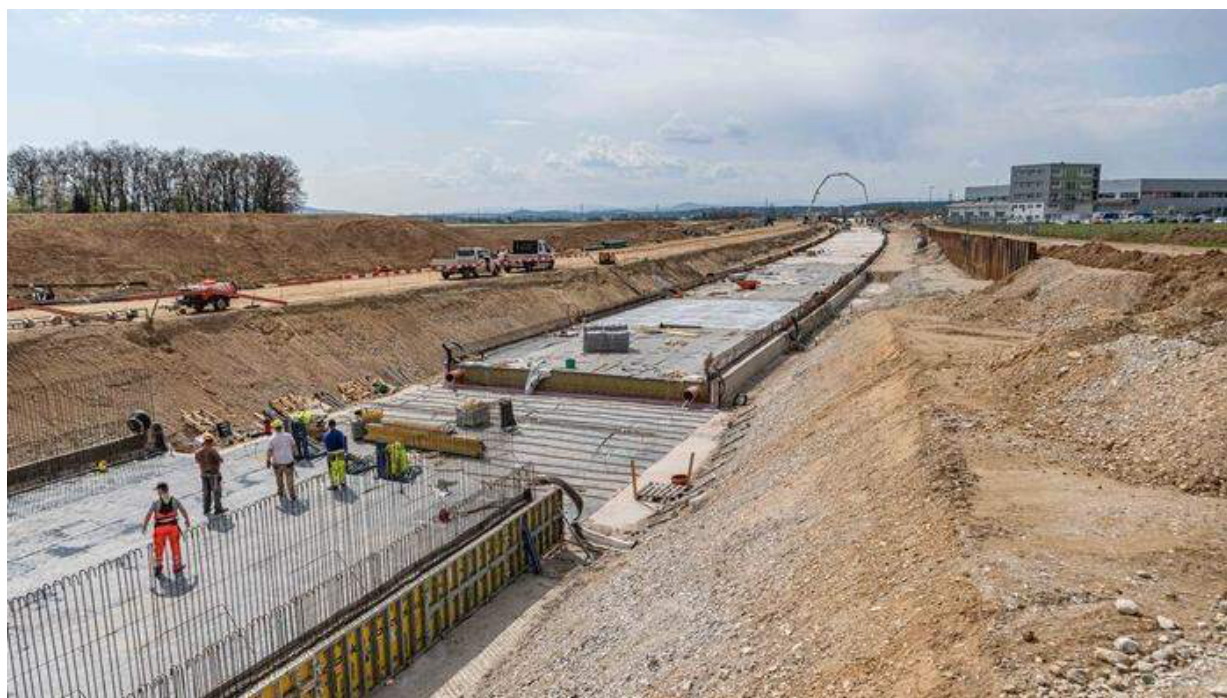
Die künftige Bahntrasse beim Flughafen Feldkirchen – eine Großbaustelle
